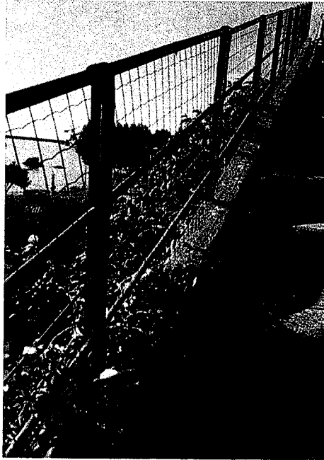
foto 6 : il tratto C nel suo insieme. La rete di protezione è di debole struttura e non adeguatamente fissata
