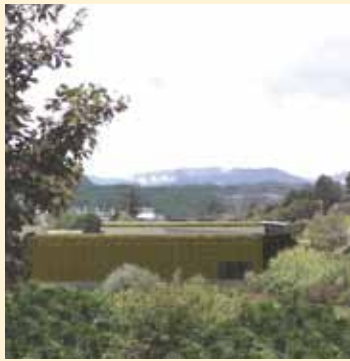
Impianto di compostaggio del Comune di La Spezia (loc. Boscalino)
